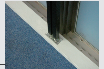
アジャスターを突っ張る面にコの字金具を 両面テープで貼付け、1台あたり上下2ヶ所 ずつ突っ張り、固定をします。
