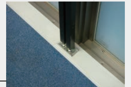
アジャスターを突っ張る面にコの字金具を 両面テープで貼付け、1台あたり上下2ヶ所 ずつ突っ張り、固定をします。
